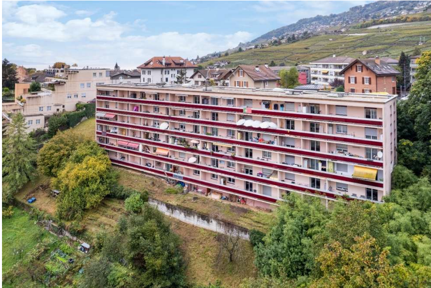
Route des Terreaux 8-10, Corsier-sur-Vevey
